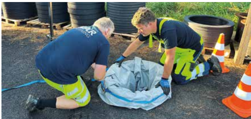
En fortrængningspose monteres nede i en tørbrønd og fyldes med sand for at holde vandet ude under et kommende uvejr. Det er KLAR Forsynings egne driftsfolk, der har udviklet denne løsning. Til venstre ses Bjarne Strange Nielsen og til højre Martin Knude Seidenfaden.
