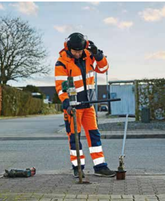
Sektionsopdeling af ledningsnettet og fjernflæste målere gør det nemmere og hurtigere at finde lækager. Foto: EWII
